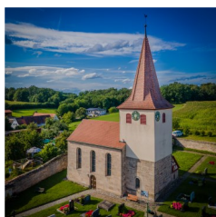
St. Andreas Unterschlaibach
